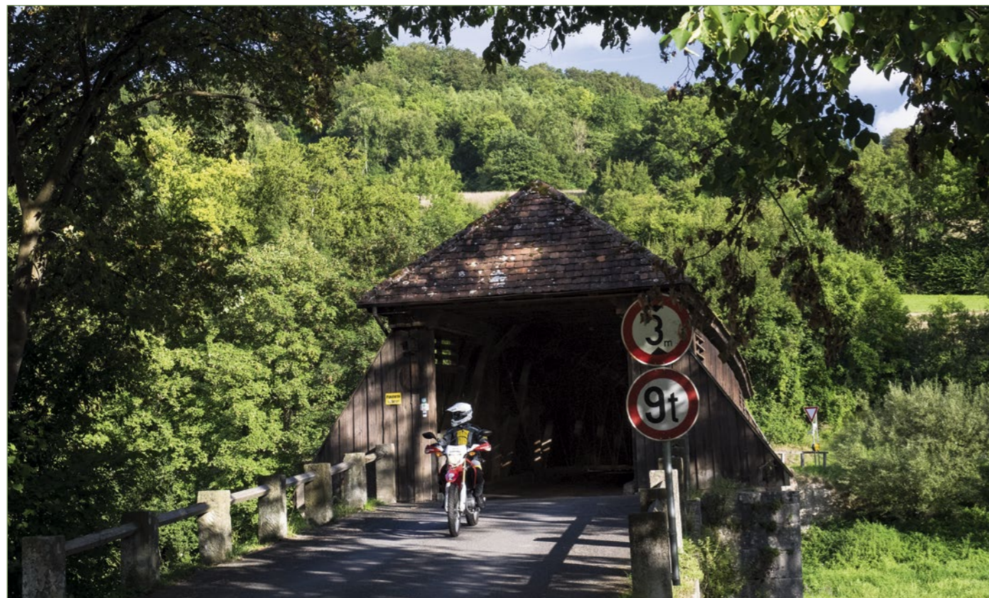
Brückenschlag: Über die hölzerne Archenbrücke bei Unterregenbach dürfen auch schwerere Reise-Enduros rollen.
